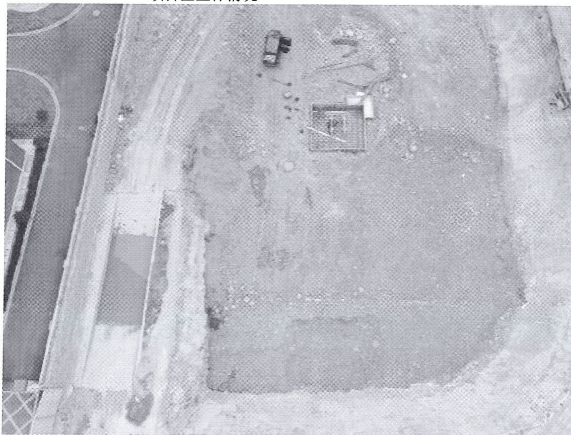
项目区入口处简易洗车设备、基础以及基坑情况
